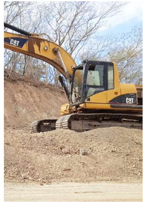
Los trabajos de la Línea K obligaron a la tala de diversas especies en el tramo de Unión Hidalgo.
